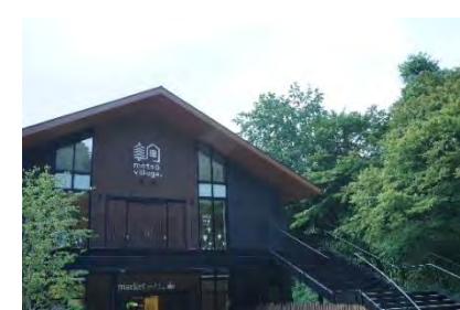
マーケット棟
